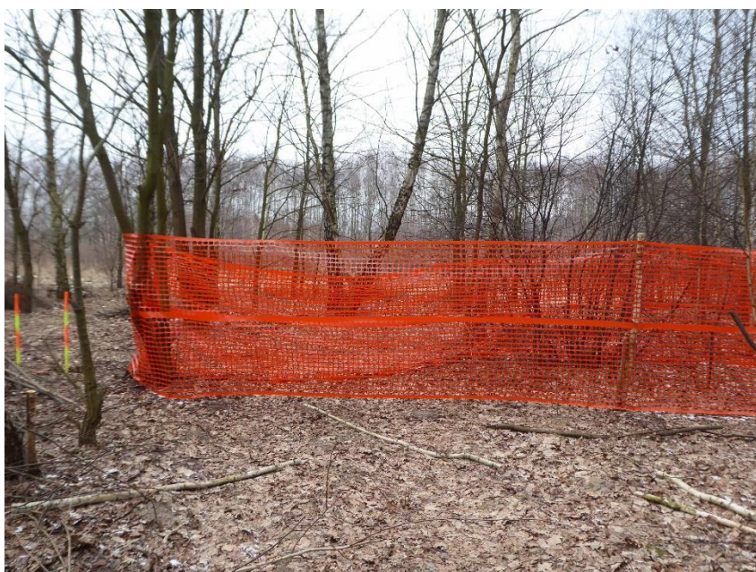
Fot. 2 Przykładowy sposób zabezpieczenia skupin drzew nieprzeznaczonych do wycinki
