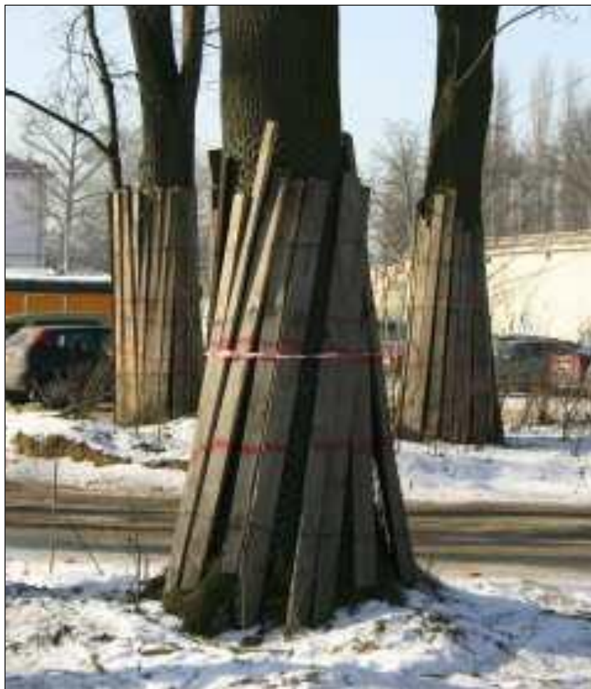
Fot. 1 Przykładowy sposób ochrony pnia drzewa przed uszkodzeniami mechanicznymi
