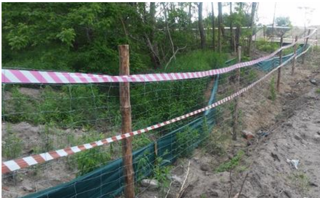
Fot. 3 Przykład wykonania tymczasowych wygradzeń dla płazów
