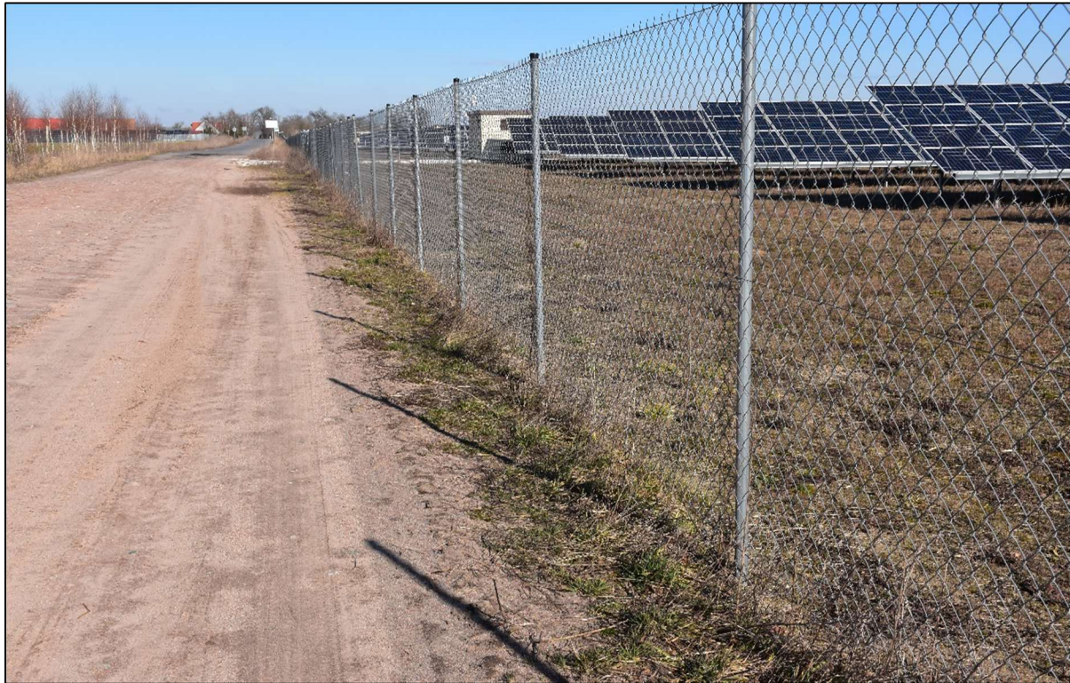
Fotografia 5. Przykładowe ogrodzenie farmy fotowoltaicznej.
