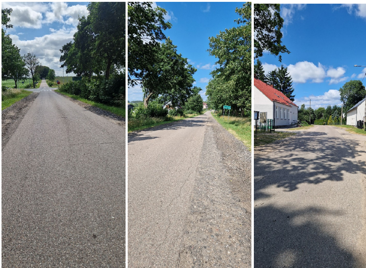
Fot. 13 – Istniejący stan drogi
